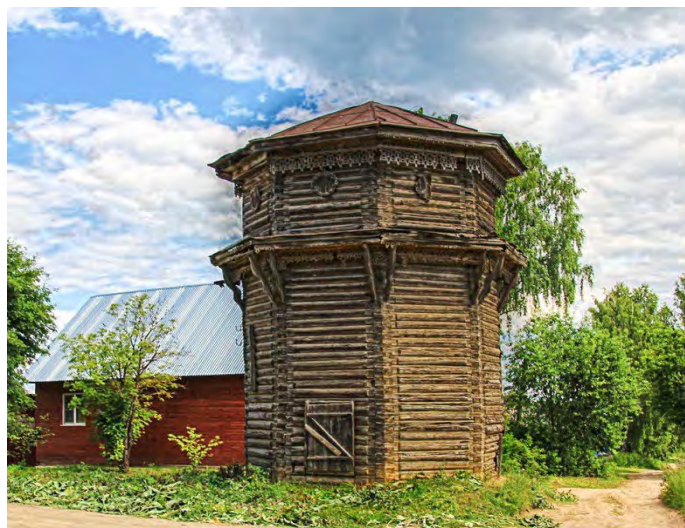
Башня-водокачка перекресток ул. Р. Люксембург и К. Либкнехта. (постройка, кон.ХІХ в.)
